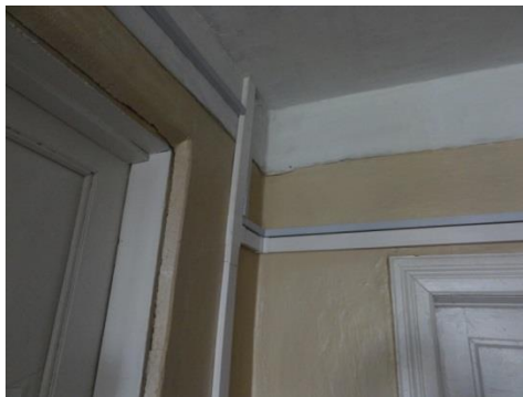
Neue Leitungen innerhalb der Gebäude
