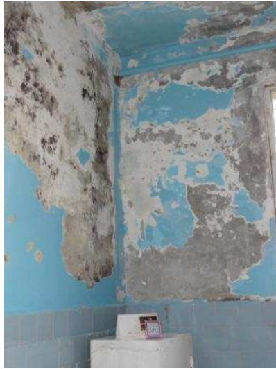
Wände im Vorbereitungsraum des Operationssaales
