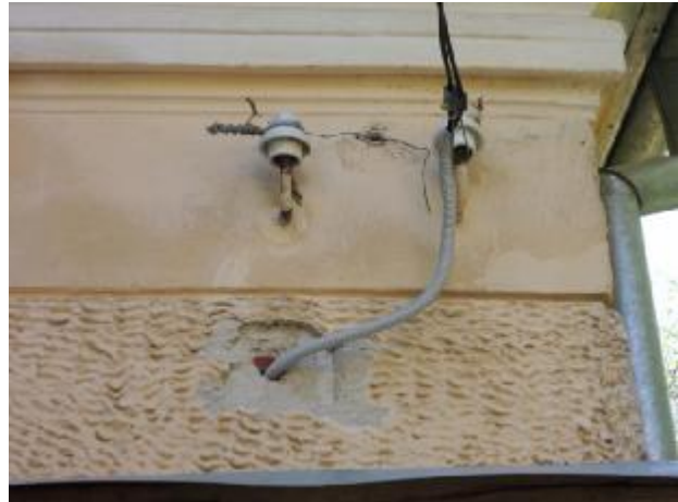
?? Ort für Glasfaserkabel ??
