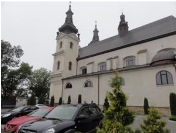
ehemaliges Studitenkloster, jetzt Guesthouse
