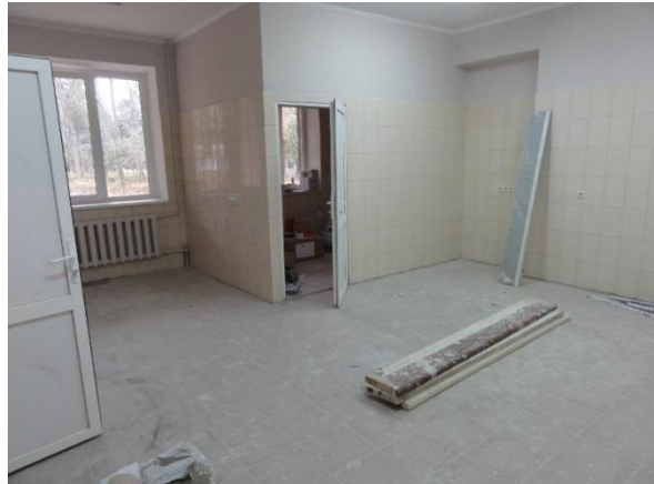
Renovation des TB Labors
